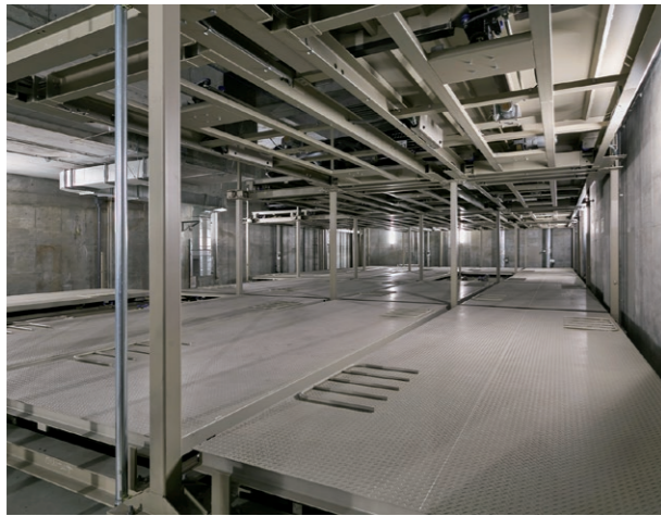
駐車場格納部 カーエレベータピットとエレベータピットを避けたレイアウト
