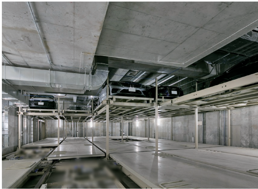
駐車場格納部 カーエレベータピットとエレベータピットを避けたレイアウト
