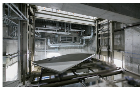
地下旋回方式（180度トレー旋回）の採用により前進での出入庫に対応
