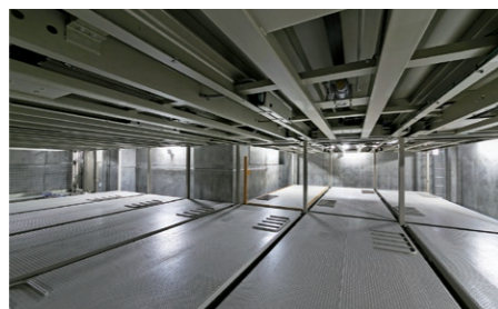
2層・31台収容の駐車スペース
